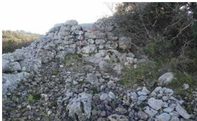
Slika 10. Sjeverno lice bastiona na koji su se naslanjala gradinska vrata
